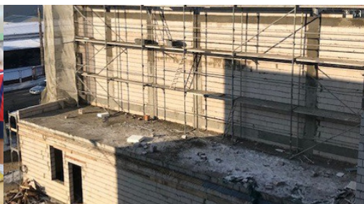
Budowa hali sportowej, 2019
